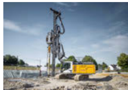
Špeciálne stroje na podzemné stavby
